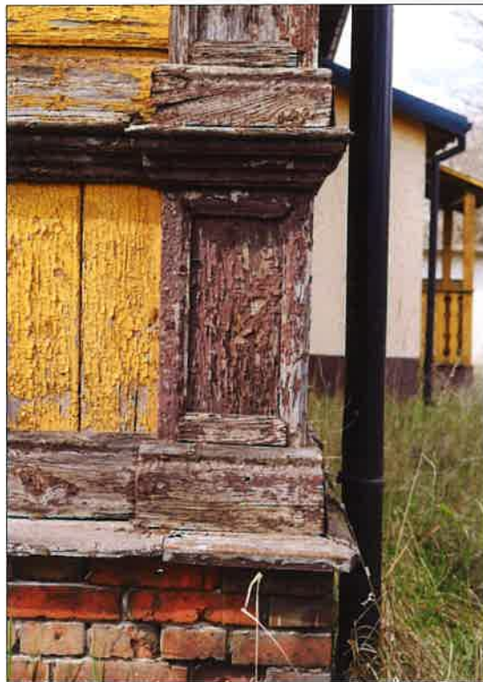
Naroże północne i wschodnie budynku z oparciem wykonanego z profilowanych desek pilastra na fundamentowej ścianie ceglanej. (fot. Jakub Andrzejewski, 2020 r.)
