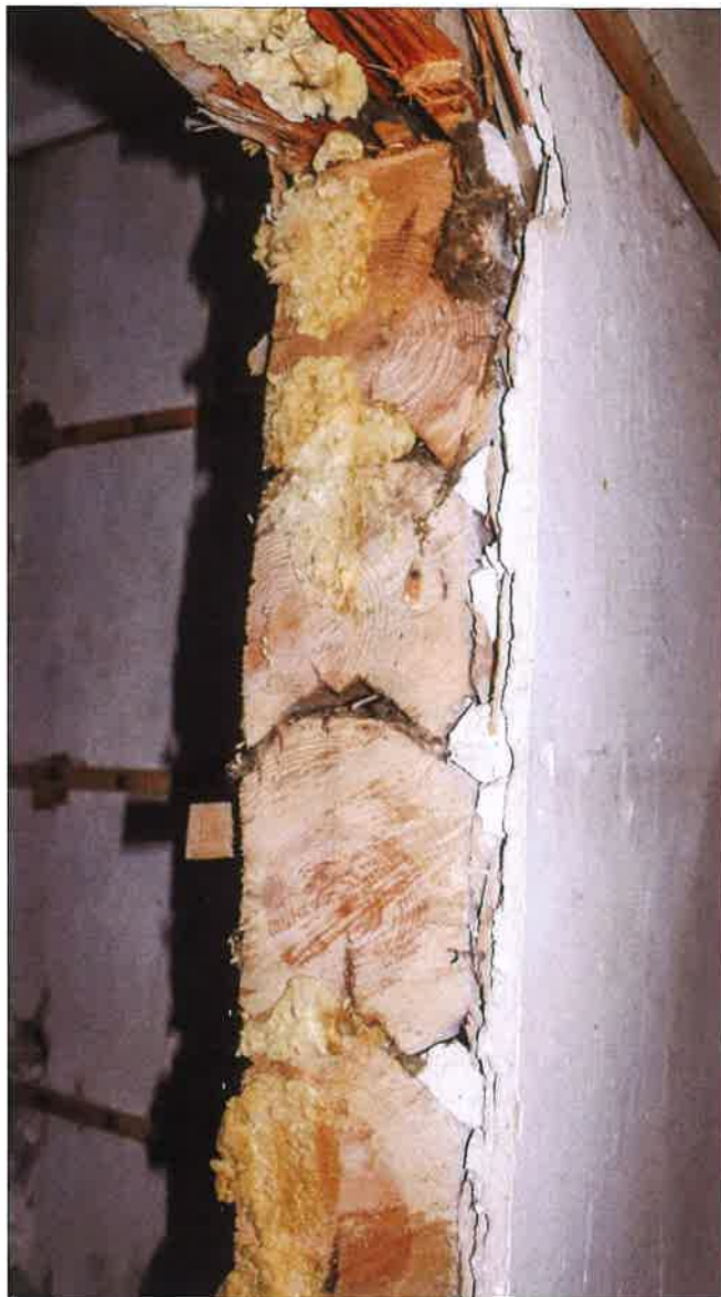
Przekrój przez ścianę wewnętrzną w miejscu zdemontowanych drzwi i ościeżnicy. (fot. Jakub Andrzejewski, 2020 r.)
