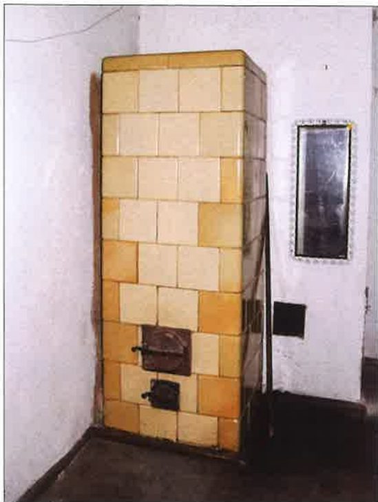
Najprawdopodobniej wtórnie wykonany piec kaflowy w pomieszczeniu w środkowej części budynku. (fot. Jakub Andrzejewski, 2020 r.)
