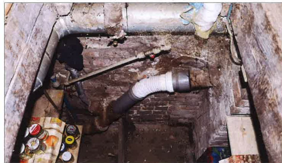
Wnętrze pomieszczenia piwnicy znajdującego się pod podłogą. (fot. Jakub Andrzejewski, 2020 r.)
