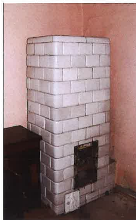
Najprawdopodobniej wtórnie wykonany piec kaflowy w pomieszczeniu w południowo-wschodniej części budynku z widocznymi zdemontowanymi drzwiczkami do paleniska i popielnika. (fot. Jakub Andrzejewski, 2020 r.)
