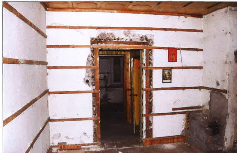
Pomieszczenie przy narożu zachodnim budynku, widok w kierunku wschodnim. (fot. Jakub Andrzejewski, 2020 r.)
