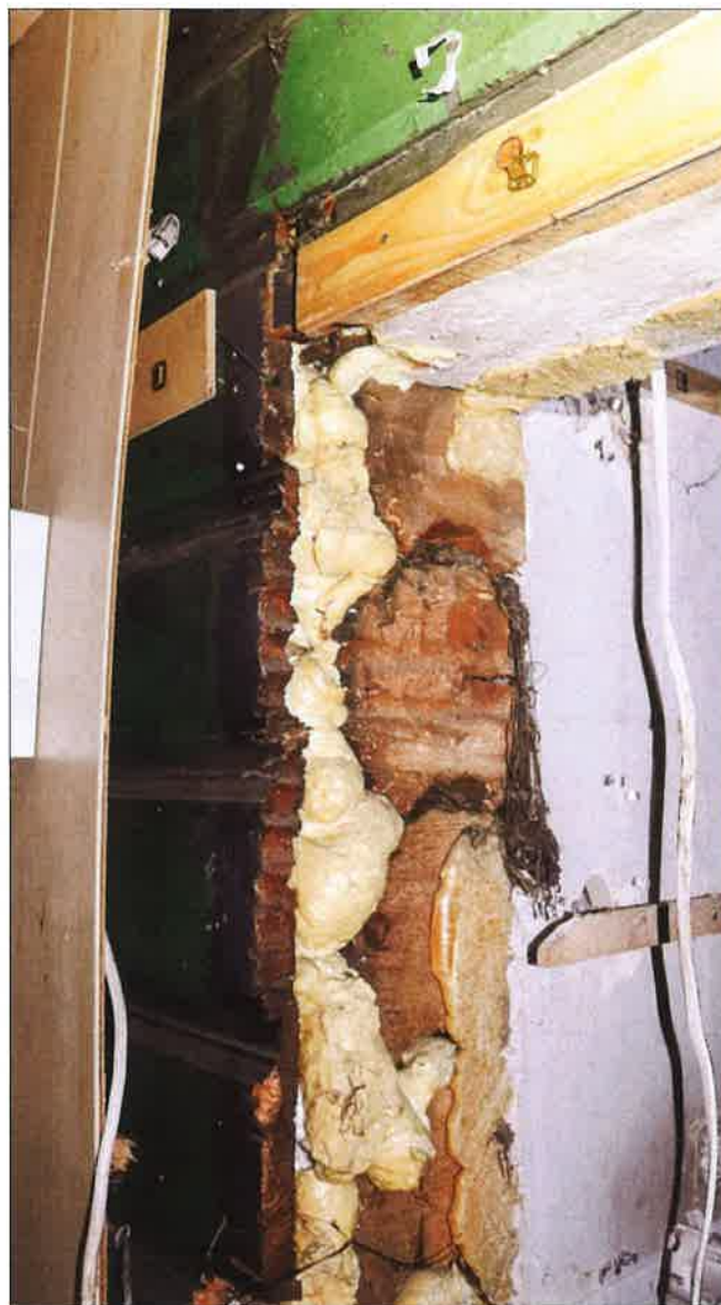
Przekrój przez ścianę zewnętrzną w miejscu wtórnego przecięcia ściany po wzniesieniu dobudówki po północno-wschodniej stronie. (fot. Jakub Andrzejewski, 2020 r.)
