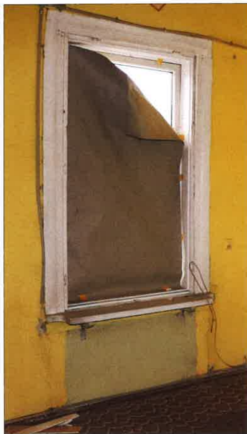
Okno w pomieszczeniu po południowo-zachodniej stronie budynku przy narożu południowym. (fot. Jakub Andrzejewski, 2020 r. )
