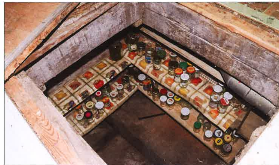
Wnętrze pomieszczenia piwnicy znajdującego się pod podłogą. (fot. Jakub Andrzejewski, 2020 r.)
