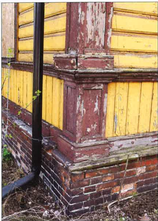
Naroże północne i wschodnie budynku z oparciem wykonanego z profilowanych desek pilastra na fundamentowej ścianie ceglanej. (fot. Jakub Andrzejewski, 2020 r.)
