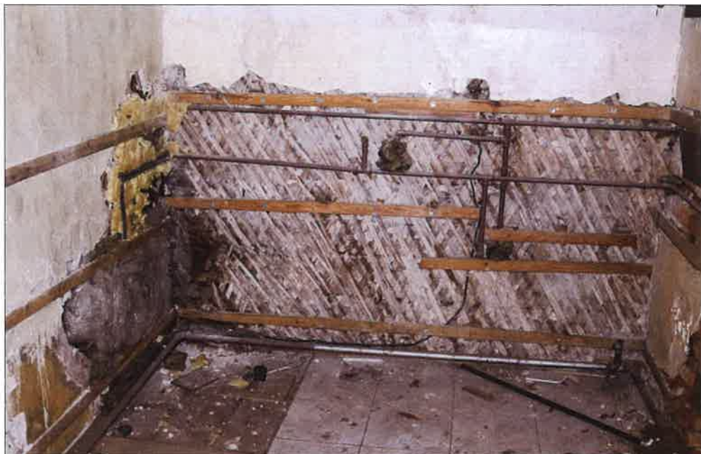
Pomieszczenie w północnym narożu budynku, widoczna podkonstrukcja pod tynkowanie ściany wykonana z drewnianych listewek. (fot. Jakub Andrzejewski, 2020 r.)
