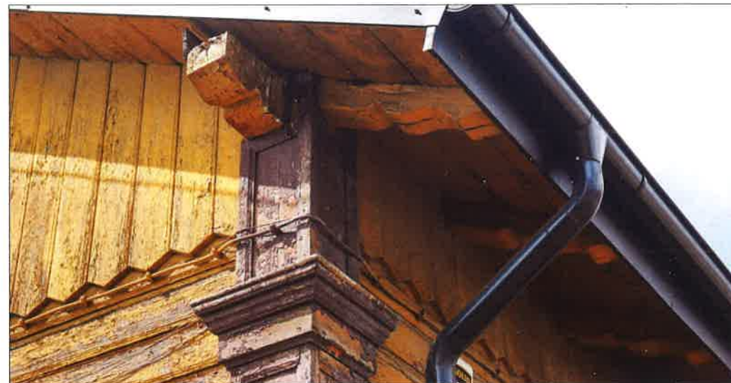
Naroże wschodnie budynku z widocznym pilastrem, zdobnie zakończonymi płatwiami oraz krokwiami oraz wtórnie wykonaną obróbką blacharską. (fot. Jakub Andrzejewski, 2020 r.)
