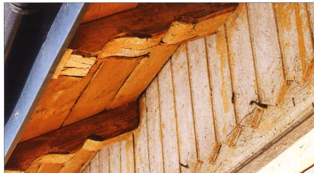
Zdobnie zakończone krokwie w elewacji południowo-zachodniej. (fot. Jakub Andrzejewski, 2020 r.)
