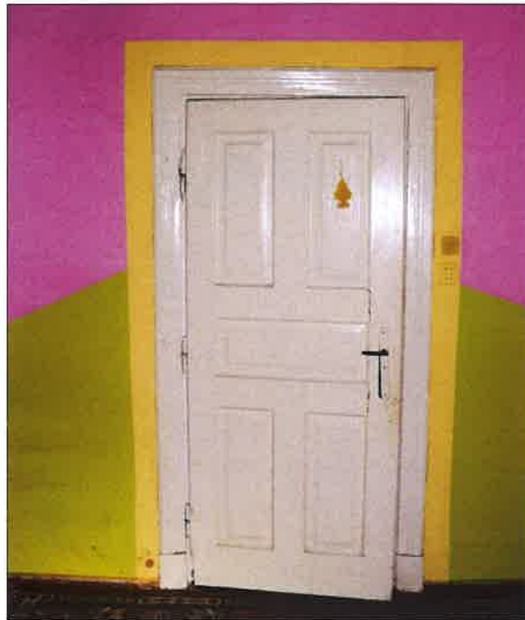
Oryginalne drzwi ramowo-płycinowe w pomieszczeniu w południowej części budynku. (fot. Jakub Andrzejewski, 2020 r.)
