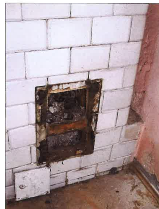
Najprawdopodobniej wtórnie wykonany piec kaflowy w pomieszczeniu w południowo-wschodniej części budynku z widocznymi zdemontowanymi drzwiczkami do paleniska i popielnika. (fot. Jakub Andrzejewski, 2020 r.)
