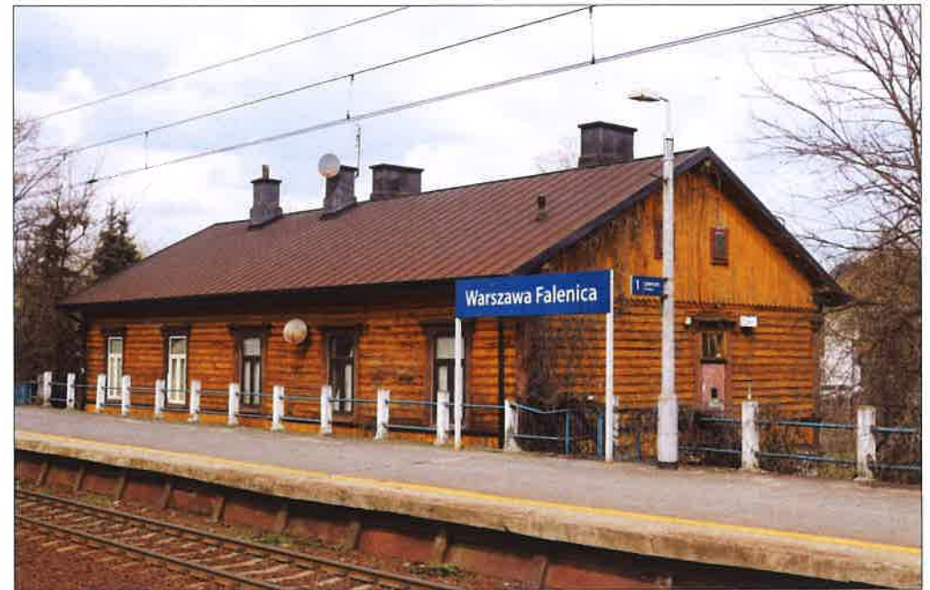
Widok budynku od strony południowej. (fot. Jakub Andrzejewski, 2020 r.)
