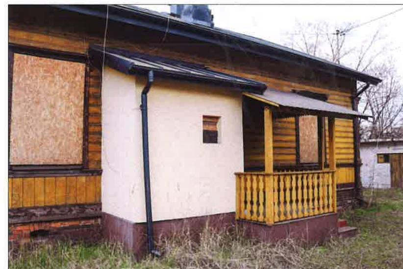
Wtórnie wzniesiona przybudówka wejściowa przy elewacji północno-wschodniej. (fot. Jakub Andrzejewski, 2020 r.)
