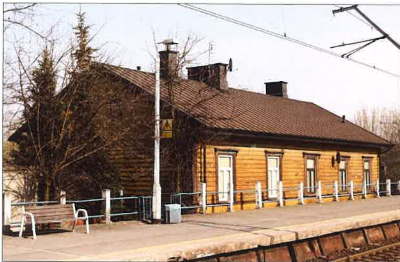
Widok budynku od strony południowo-wschodniej.
