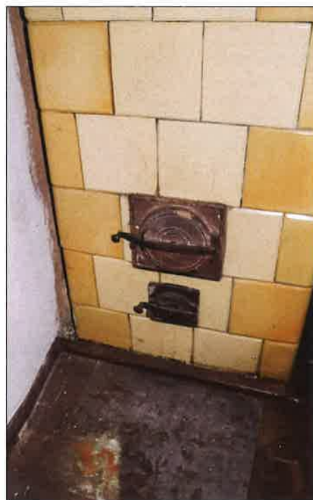
Najprawdopodobniej wtórnie wykonany piec kaflowy w pomieszczeniu w środkowej części budynku. (fot. Jakub Andrzejewski, 2020 r.)
