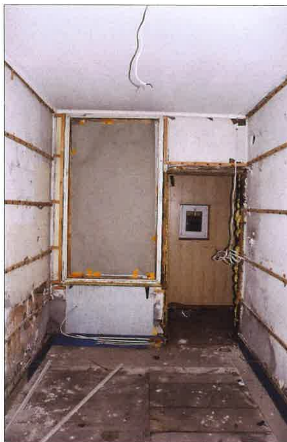
Okno oraz wtórnie wykonane przejście do przybudówki w środkowej części ściany zewnętrznej po północno-wschodniej stronie budynku. (fot. Jakub Andrzejewski, 2020 r.)
