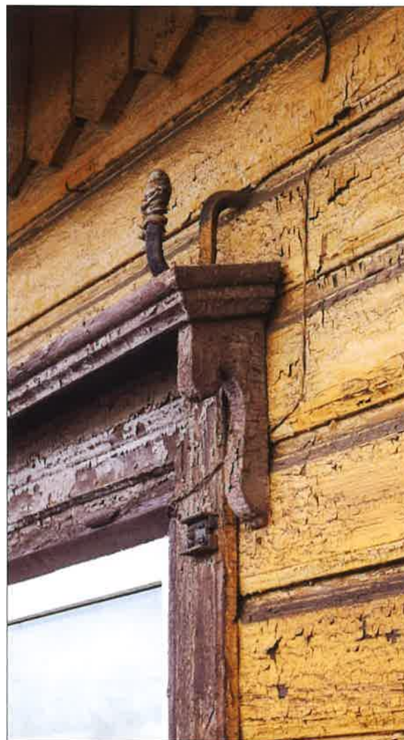
Detal obramowania okna w elewacji południowo-zachodniej, powyżej widoczny hak po zdemontowanym izolatorze telefonicznym. (fot. Jakub Andrzejewski, 2020 r.)
