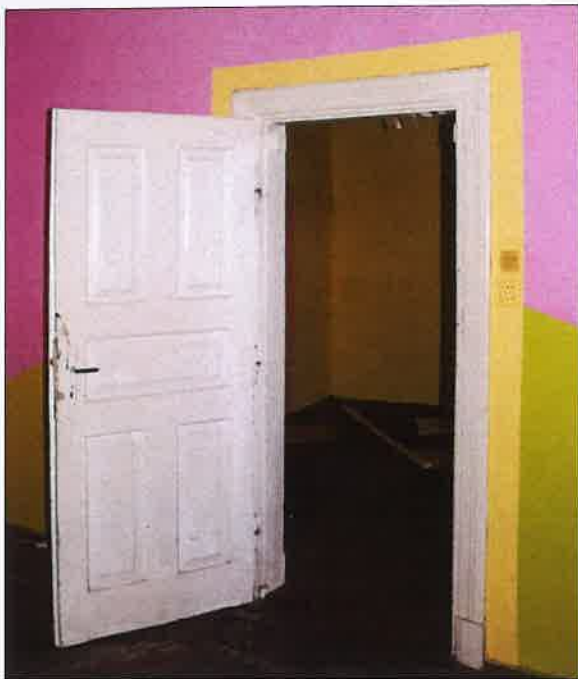
Oryginalne drzwi ramowo-płycinowe w pomieszczeniu w południowej części budynku. (fot. Jakub Andrzejewski, 2020 r.)
