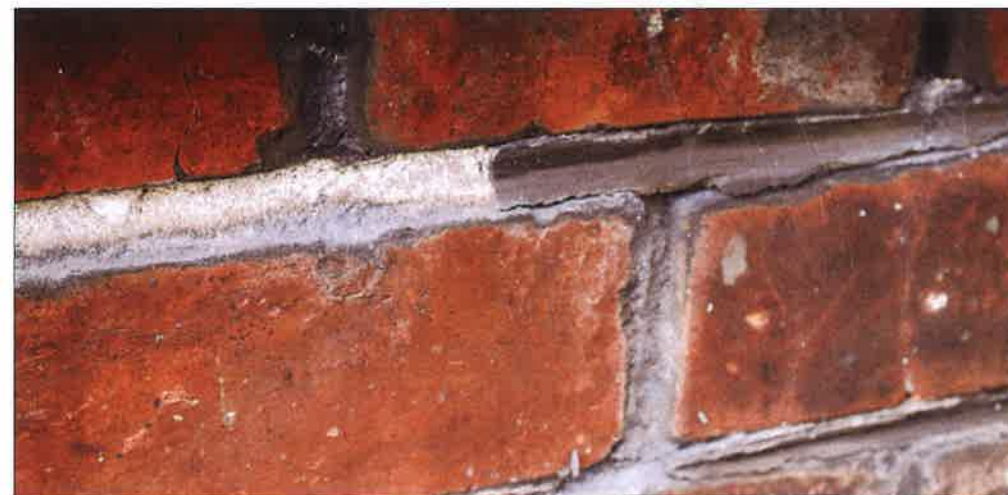
Zaprawa wapienna oraz fragmenty spoinowania cementowego. (fot. Jakub Andrzejewski, 2020 r.)
