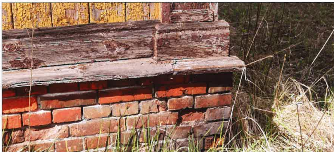
Naroże wschodnie budynku z widocznym ceglany cokołem i drewnianą deską - okapnikiem. (fot. Jakub Andrzejewski, 2020 r.)
