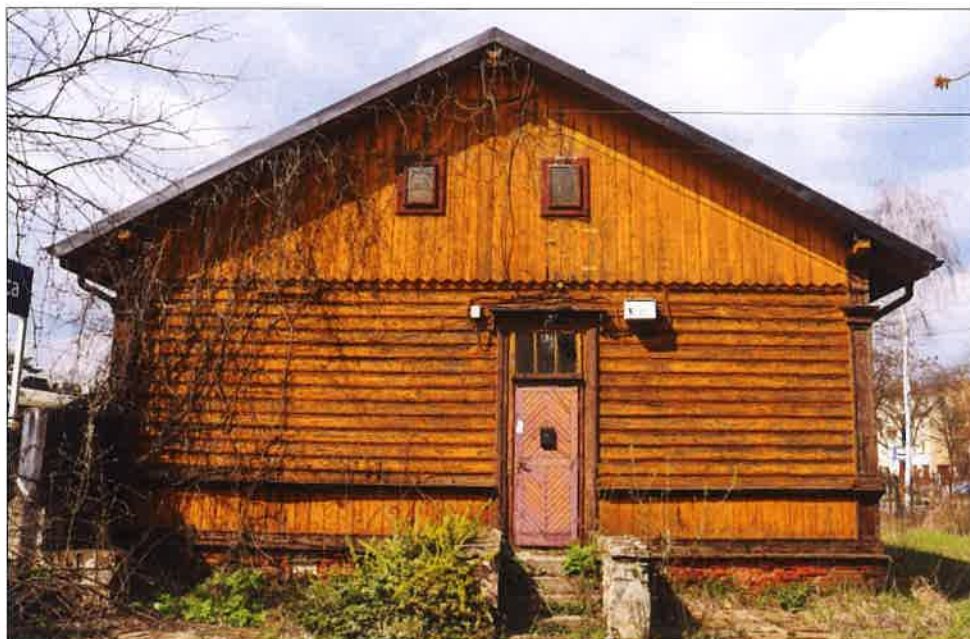
Elewacja południowo-wschodnia budynku. (fot. Jakub Andrzejewski, 2020 r.)
