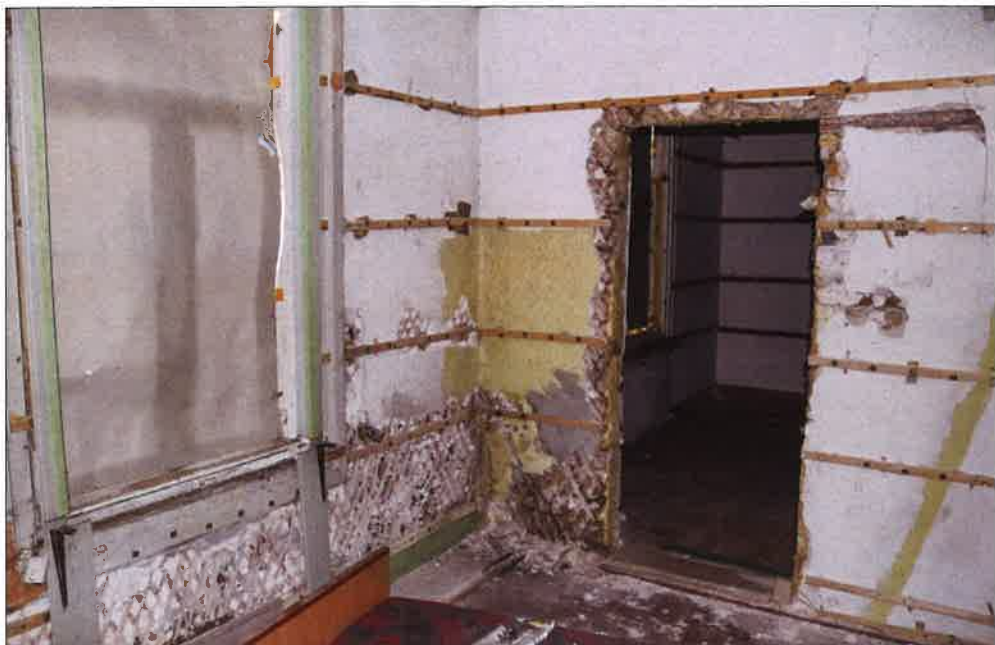
Pomieszczenia przy południowo-zachodniej ścianie zewnętrznej budynku, widoczne wtórnie zdemontowane drzwi oraz fragmenty ścian. (fot. Jakub Andrzejewski, 2020 r.)
