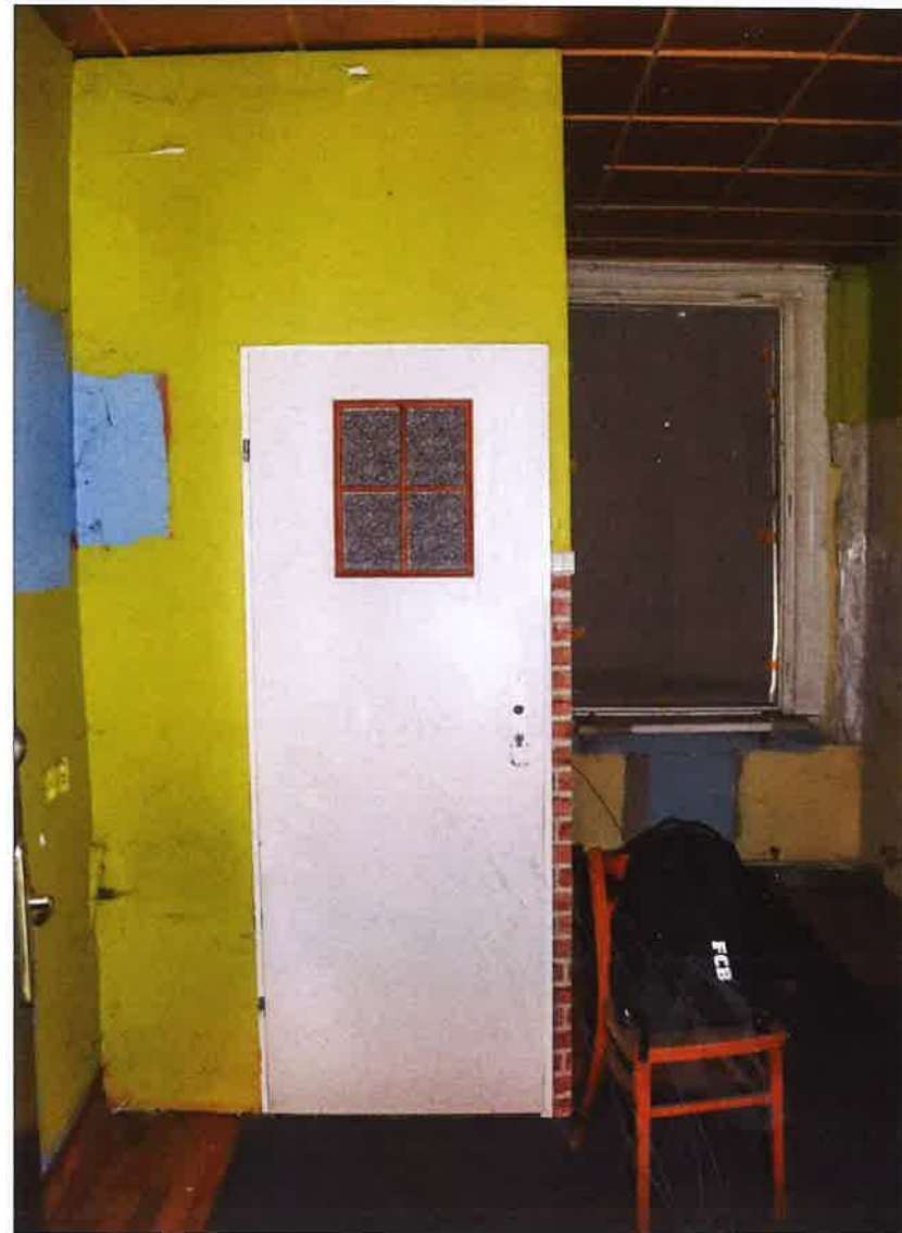
Pomieszczenie w południowym narożu budynku z widocznym, wtórnie wykonanym pomieszczeniem łazienki. (fot. Jakub Andrzejewski, 2020 r.)
