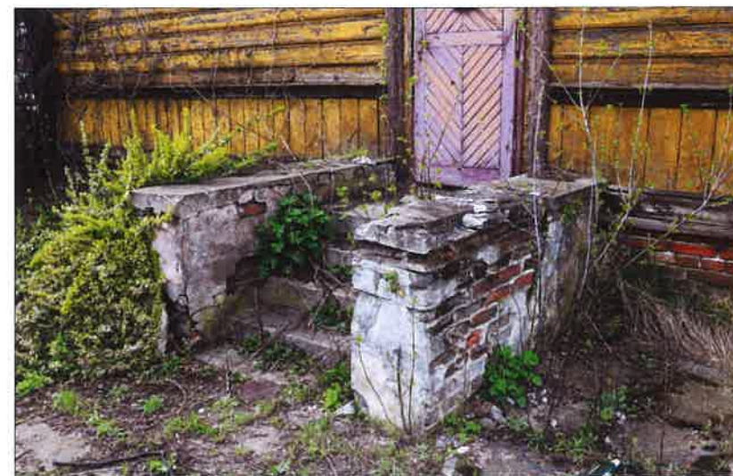
Murowane schody przy wejściu do budynku w elewacji południowo-wschodniej. (fot. Jakub Andrzejewski, 2020 r.)
