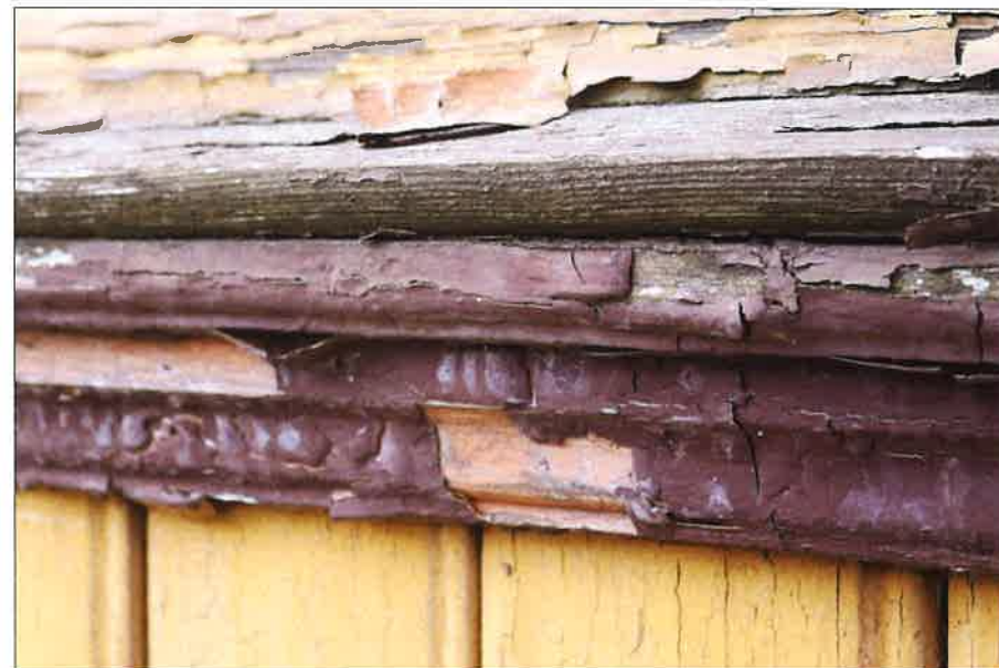
Elementy zdobnego gzymsu w elewacji wykonane z profilowanych listew oraz desek. (fot. Jakub Andrzejewski, 2020 r.)
