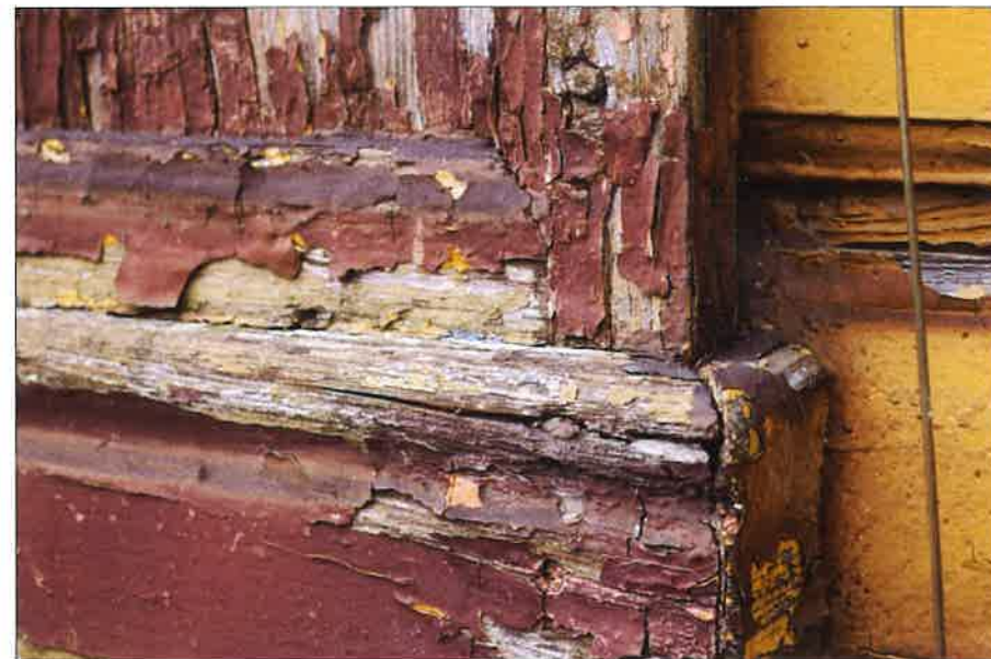
Fragment narożnego pilastra wykonanego z profilowanych desek z widocznymi licznymi warstwami farby. (fot. Jakub Andrzejewski, 2020 r.)
