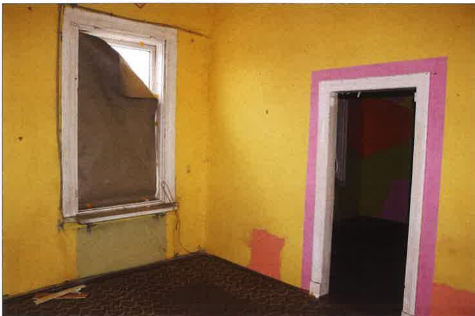
Pomieszczenie przy południowym narożu budynku i południowo-zachodniej ścianie zewnętrznej. (fot. Jakub Andrzejewski, 2020 r.)
